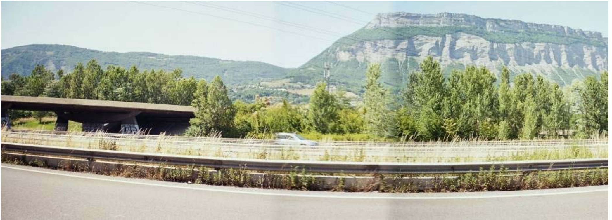
Vue depuis la liaison entre Rocade Sud et A 41 vers l'échangeur
